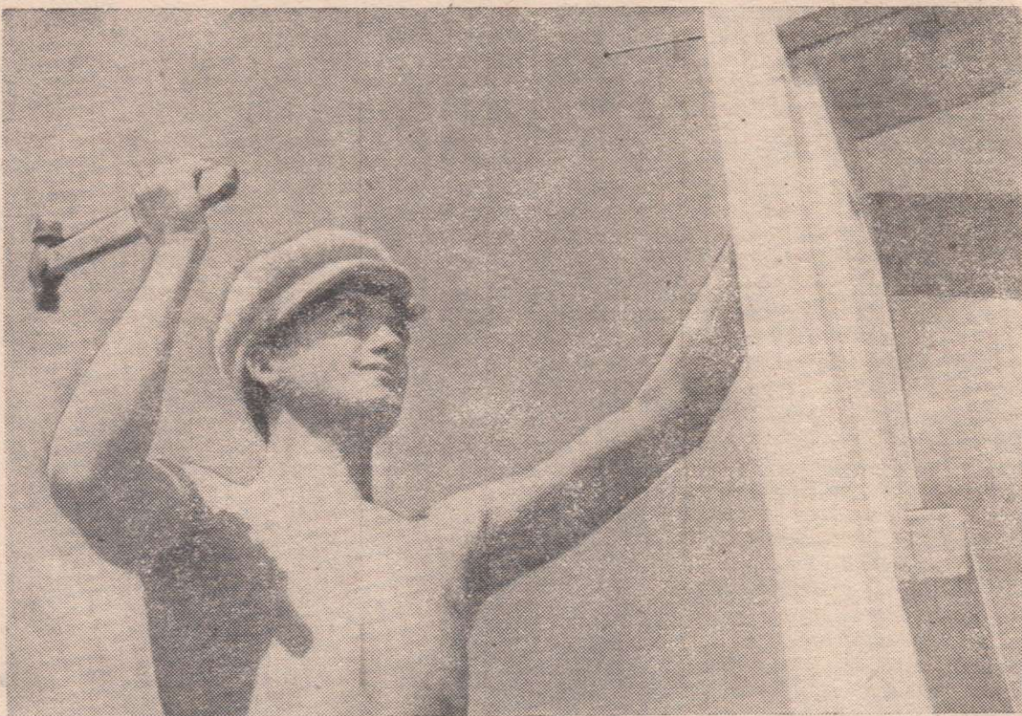
НА СТРОЙКЕ. ЖАРКОЕ ЛЕТО.
